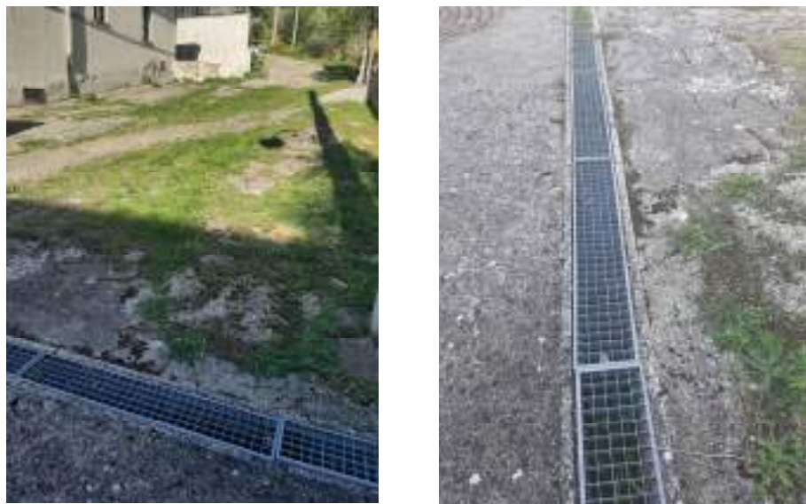
Figura 4: Griglia per raccolta acqua sottodimensionata e posizionata non alla fine della pendenza
