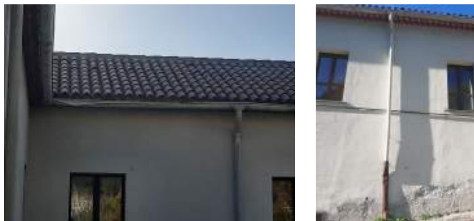
Figura 6: canali e discendenti deformati
