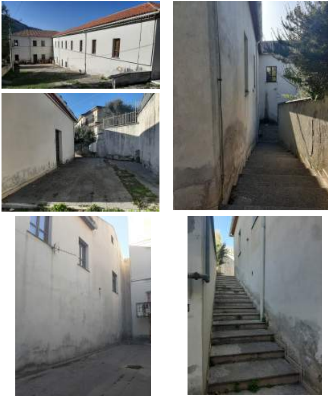
Figura 3: Umidità di risalita sulle pareti portanti esterne
