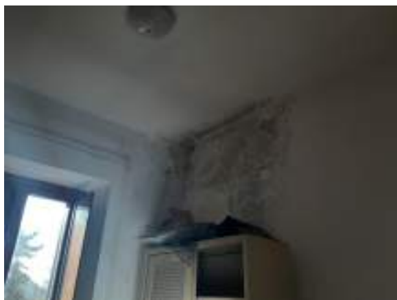
Figura 7: Camera del primo piano con problemi di infiltrazioni di acqua dal tetto
