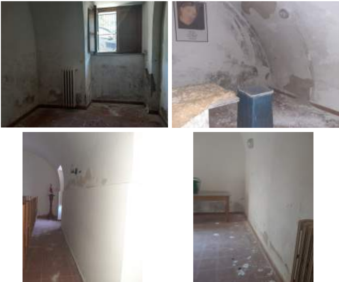
Figura 2: umidità di risalita sulle pareti portanti – vista dall'interno
