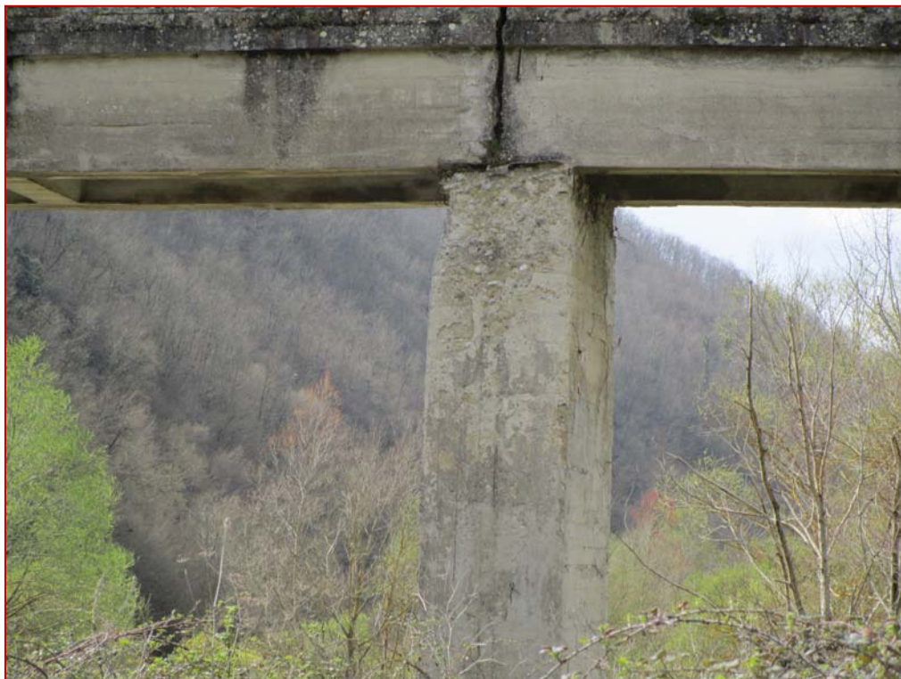
Degrado delle pile
