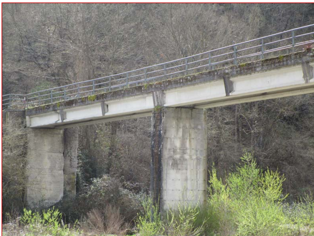
Degrado delle pile
