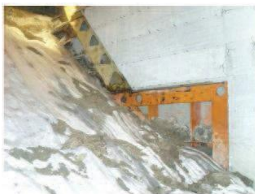
Figura 11: Messa in sicurezza e protezione del fronte di scavo per una pausa lunga
