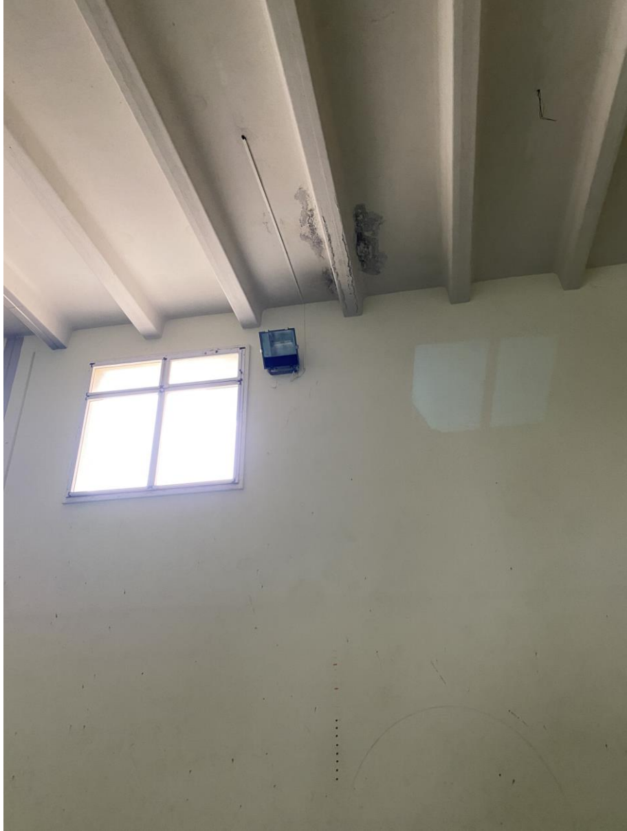
Infiltrazione acqua in palestra.
