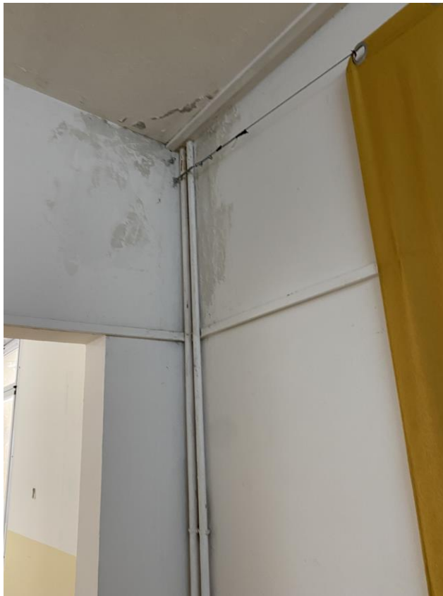
Infiltrazione acqua piano primo
