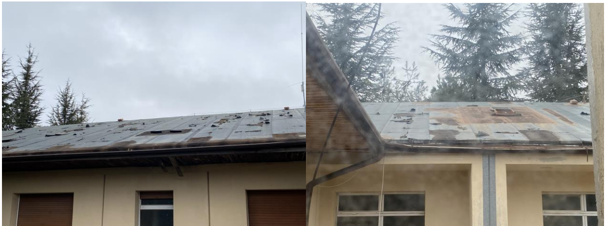
Guaina ammalorata su parte della copertura
